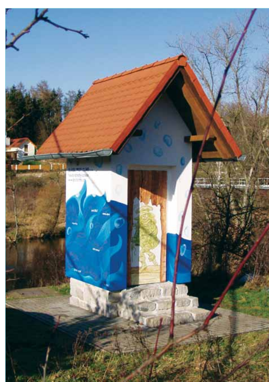
Vodoměrná měřicí stanice Doubravka na Berounce.
